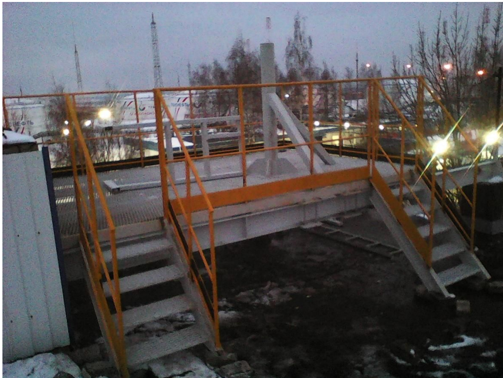
“Транснефть” - Основание мачты антенной системы на крыше здания. Проектирование, согласование, монтаж.
